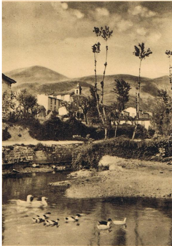
Sigillo - Uno scorcio del Borgo sopra l'antico ponte della Formola
