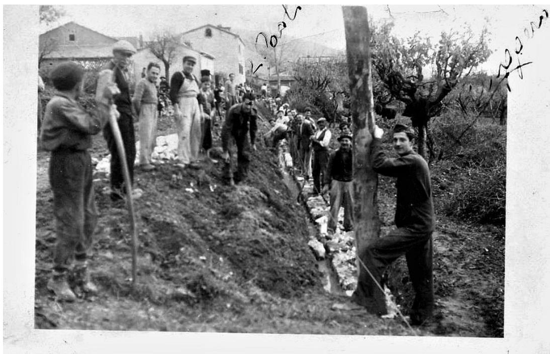
Sigillani intenti alla costruzione della strada che "mena al Cimitero"
