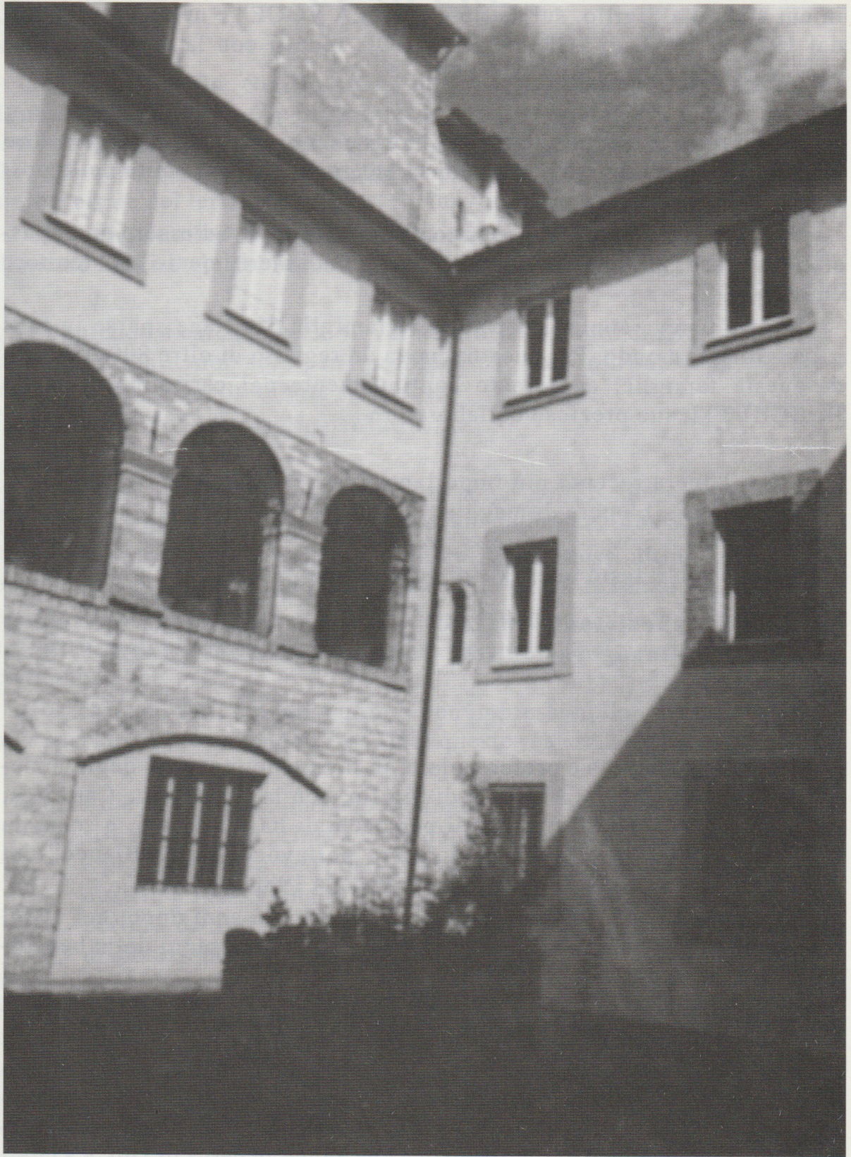
SIGILLO. Il chiostro di S. Agostino dopo i restauri. Ora Centro Residenziale per Anziani "CASA BENEDETTA".
